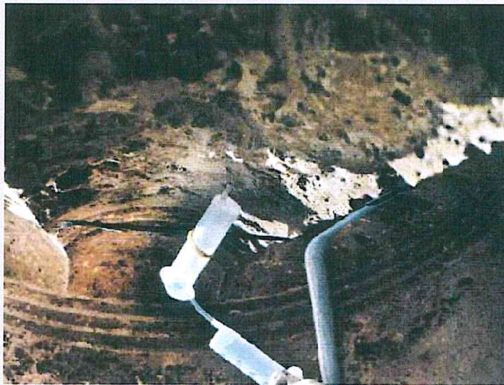
Consolidamento del materiale lapideo
